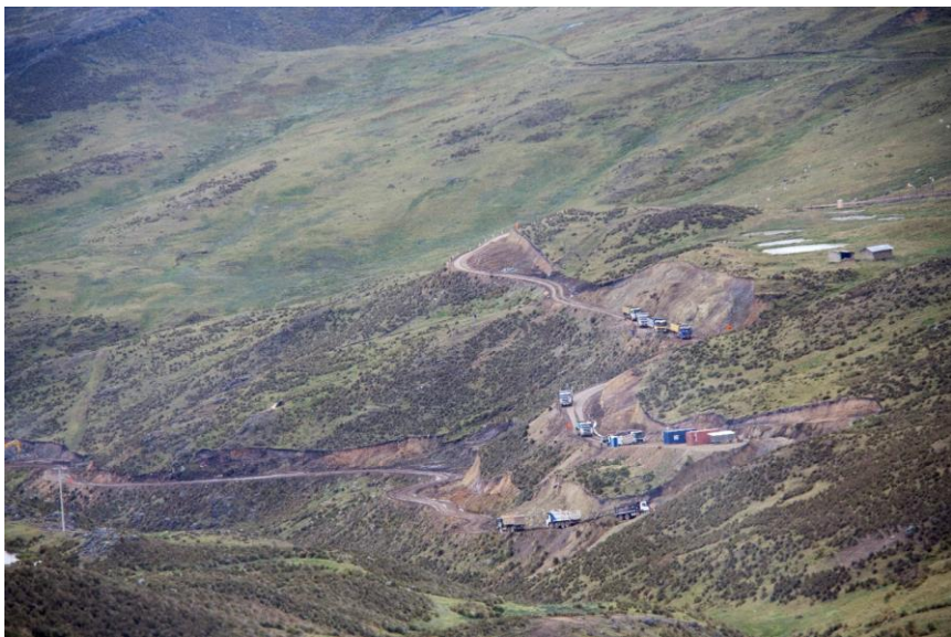
中国能建葛洲坝集团承建的秘鲁奥永至安博公路升级改造项目
