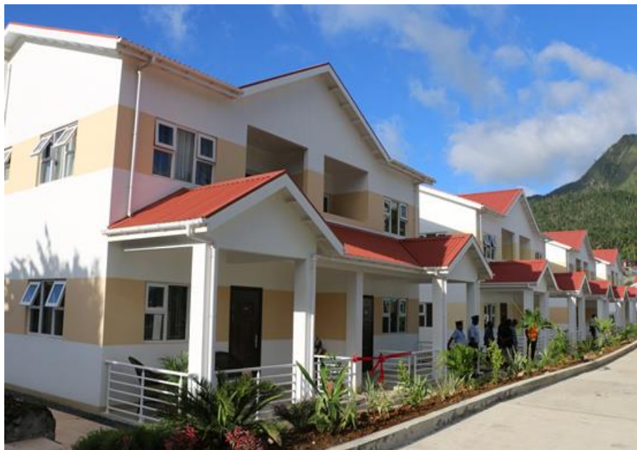
2018年12月，中土公司承建主体工程的贝尔维尤肖邦安置房项目首批住房正式移交并入住
