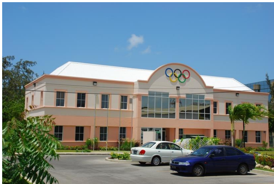
中建承包项目——奥林匹克管理楼
