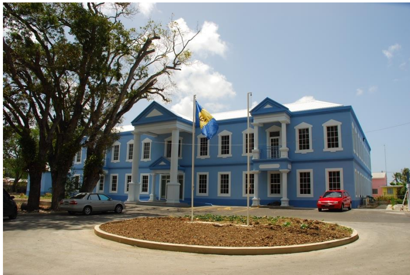
中建承包项目——工会新办公楼
