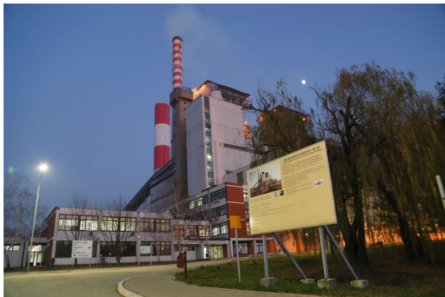
中国机械设备股份有限公司—科斯托拉茨电站一期项目电厂
