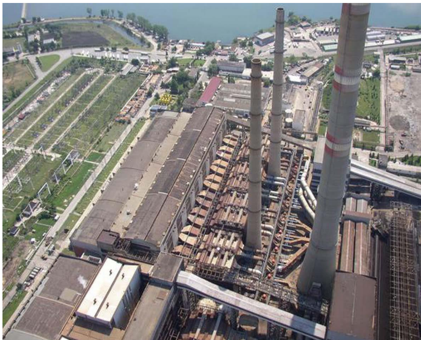
浙大网新承建保最大火电站烟气脱硫项目
