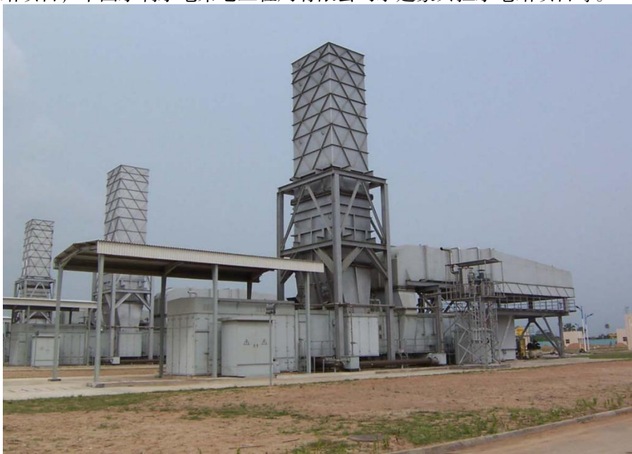
帕帕兰多燃机电站一期工程
