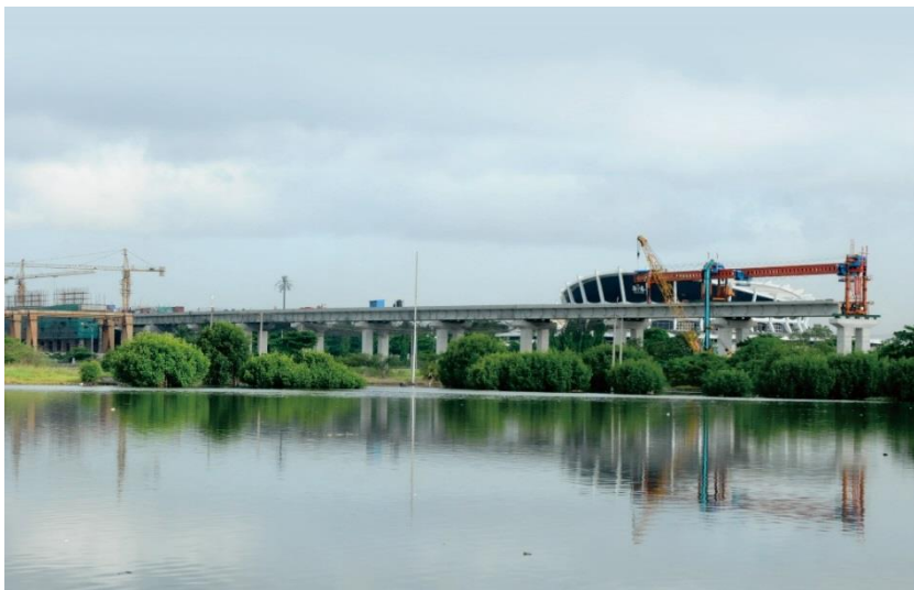
拉各斯轻轨施工场景
