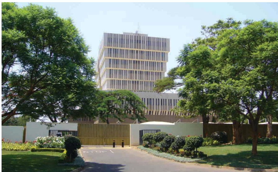
马拉维储备银行总部大楼
