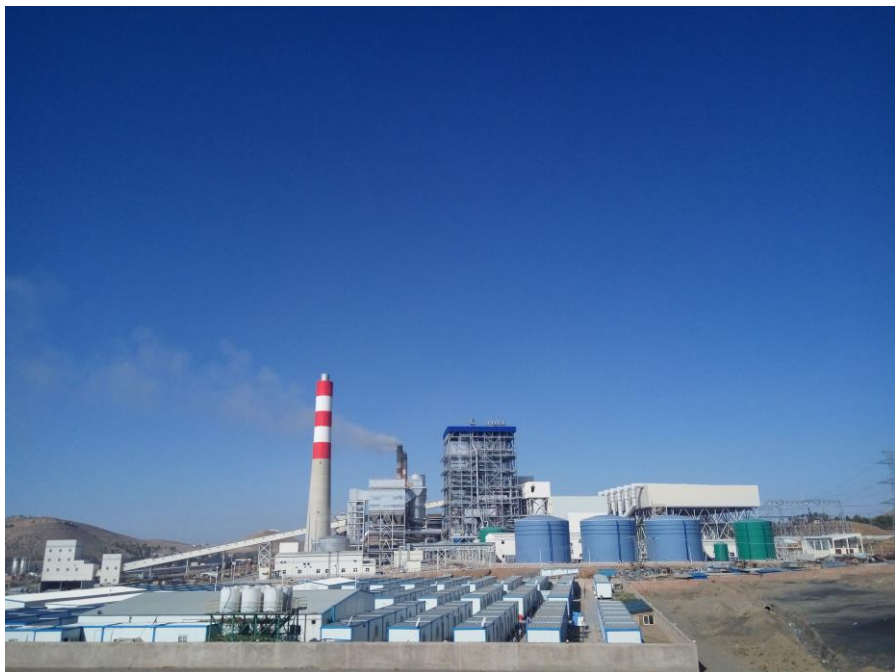
山东三建承建的杰拉达火电站项目
