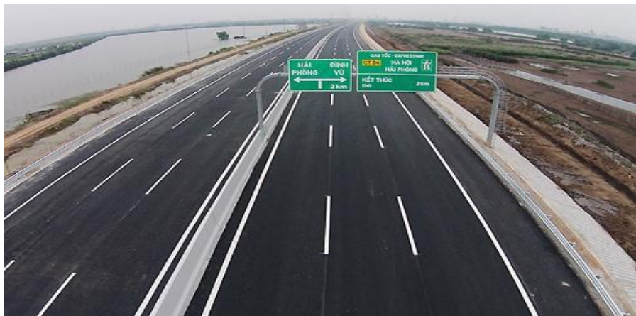
河内-海防高速公路
